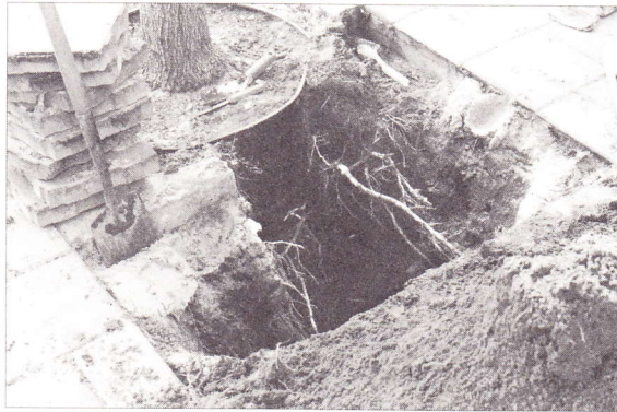
De wortels die onder het DeepRoot scherm doorgroeien
